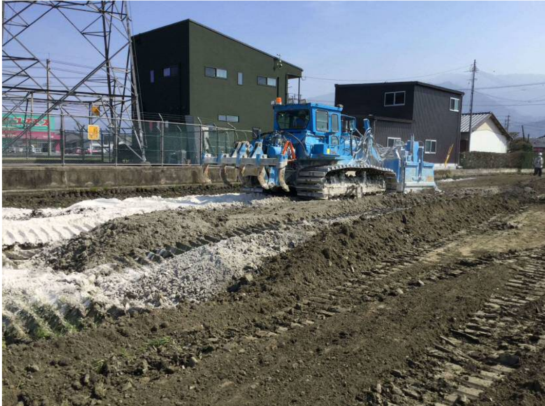
スタビライザーによる施工状況（固化材の混合）
