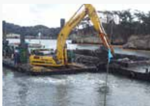
港湾浚渫土を良質改良土へ
