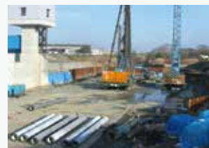
杭打ち重機足場改良
