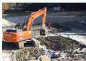
ため池工事池底改良
