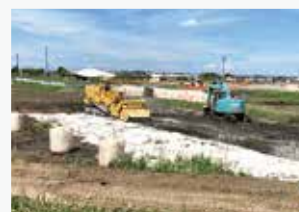
農地・水辺周辺の工事に
