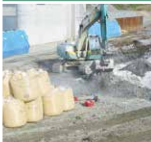
バックホウによる原位置改良
