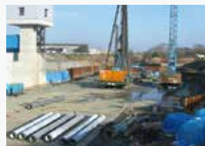
杭打ち重機足場改良
