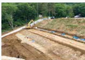
改良土を堤体盛土に使用
