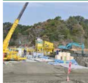
改良プラントによる大量処理
