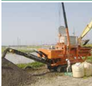
自走式改良機による発生土改良
