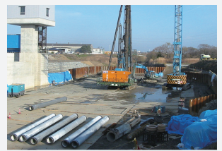
杭打ち重機足場改良
