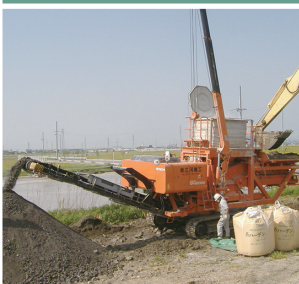
自走式改良機による発生土改良
