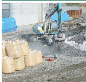
バックホウによる原位置改良
