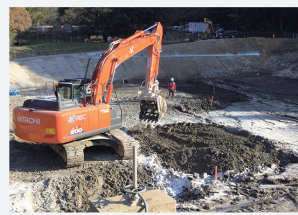
ため池工事池底改良
