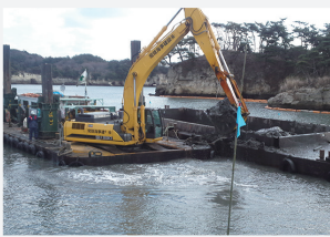
港湾浚渫土を良質改良土へ
