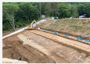
改良土を堤体盛土に使用
