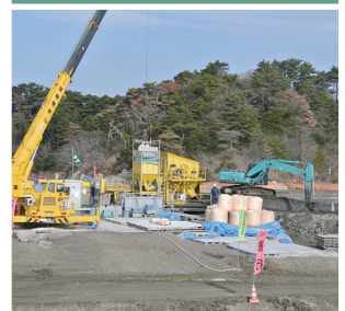
改良プラントによる大量処理
