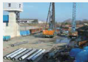
杭打ち重機足場改良
