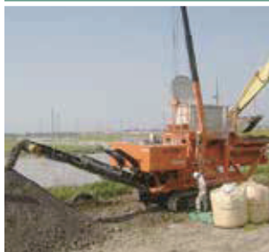
自走式改良機による発生土改良
