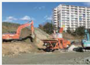
残土処分せず工事内利用
