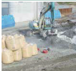
バックホウによる原位置改良
