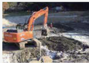
ため池工事池底改良
