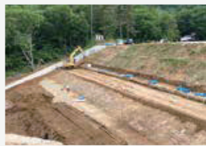
改良土を堤体盛土に使用
