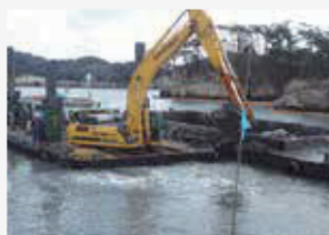
港湾浚渫土を良質改良土へ
