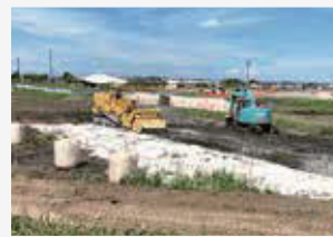
農地・水辺周辺の工事に
