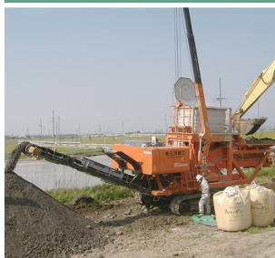
自走式改良機による発生土改良
