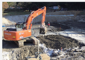
ため池工事池底改良
