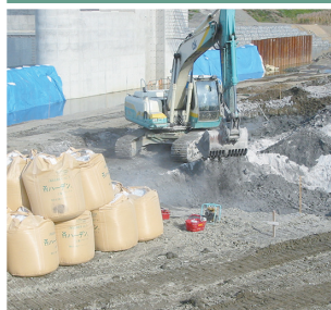
バックホウによる原位置改良
