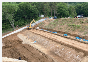
改良土を堤体盛土に使用
