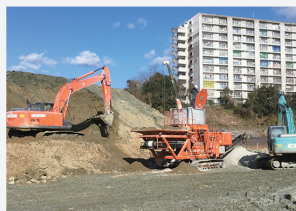
残土処分せず工事内利用
