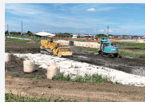
農地・水辺周辺の工事に
