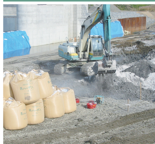
バックホウによる原位置改良
