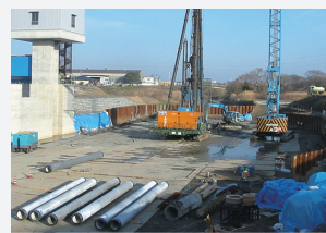
杭打ち重機足場改良
