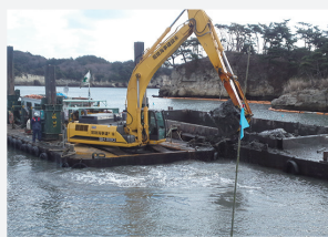
港湾浚渫土を良質改良土へ
