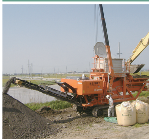
自走式改良機による発生土改良
